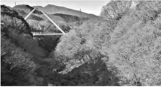
▲ 高津戸橋から見る高津戸峡
