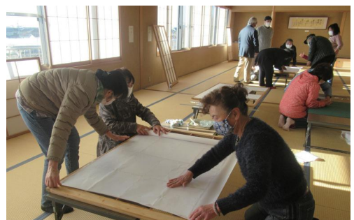
▲和室の障子張り
