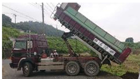
土砂の受入れ状況
