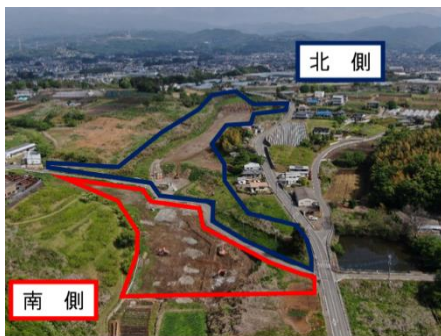
盛土造成予定地
