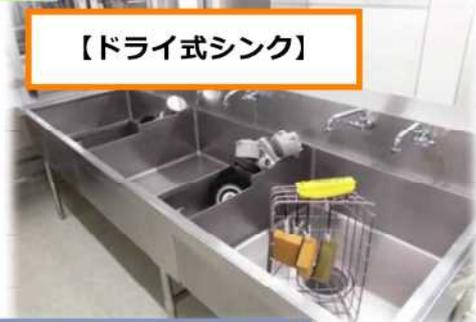
◆建て替えにより、ドライシステムを採用（釜一つ一つに専用の排水、水はけのよい床面、水がこぼれにくいドライ式シンクなど）衛生的な施設となっている。
