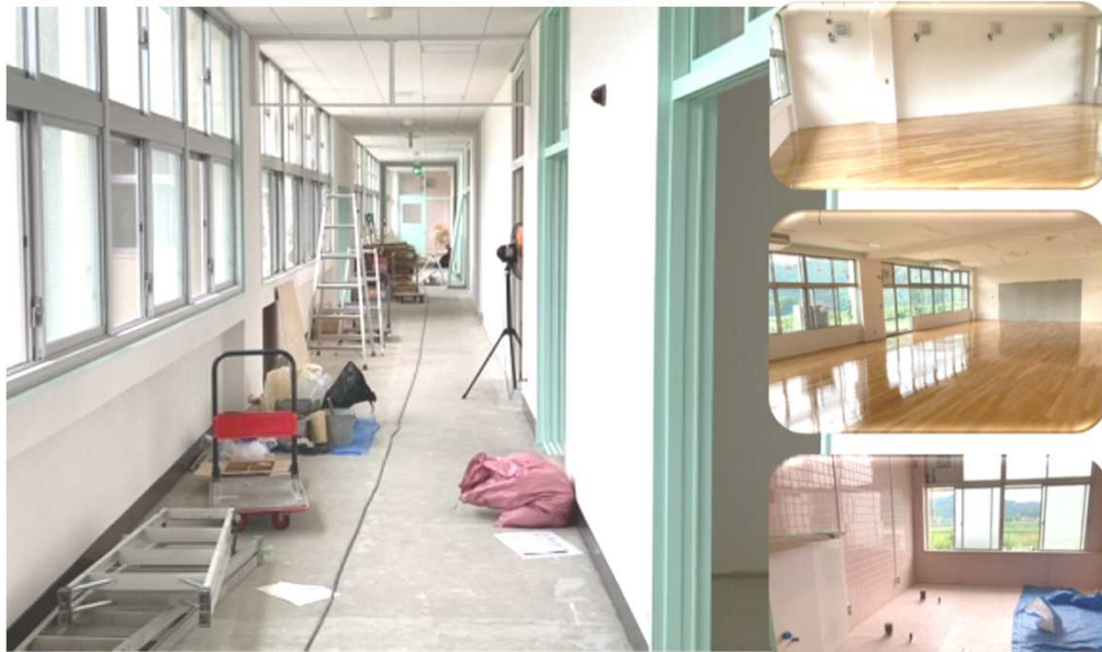
改修工事の真っ最中(3階廊下西側から東側を展望)
