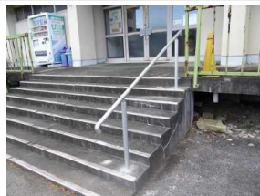
体育館入り口に 手すりを設置
