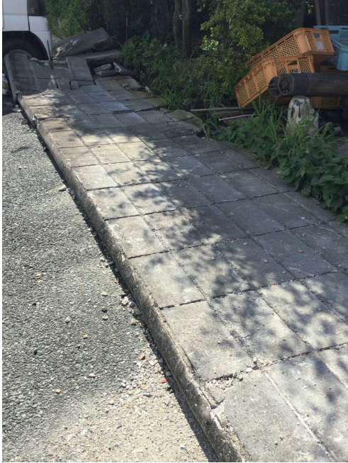
地震によりブロック塀が倒壊
