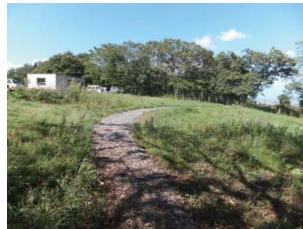
ウッドチップの施工例
