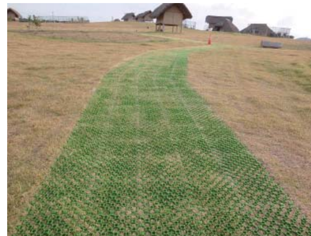
芝保護材の施工例（長崎県 原の辻遺跡 左：敷設直後 右：敷設 1 年後）
