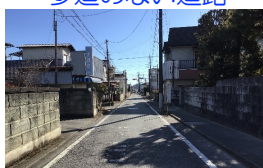
歩道のない道路
