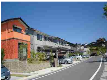
周辺環境と調和していない 奇抜な色彩の建物
