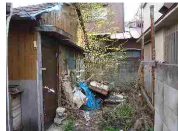
管理が行き届いて いない空き家
