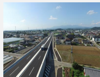
（H29年度の完成区間）
