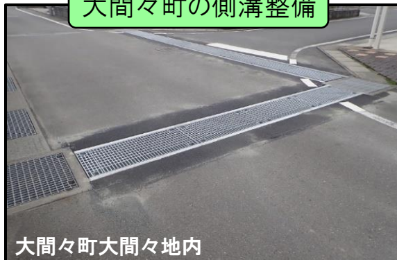
大間々町の側溝整備
