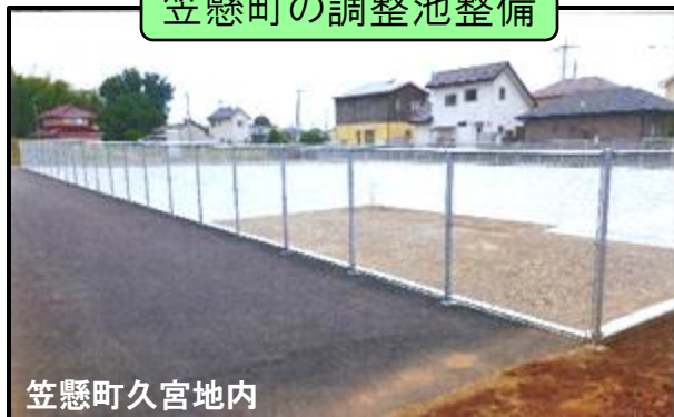
笠懸町の調整池整備
