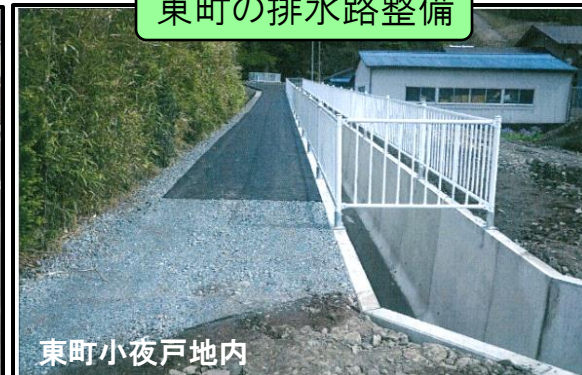
東町の排水路整備
