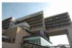
八尾市立病院維持管理・運営事業
