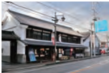
岡直三郎商店工場店舗兼住宅（明治中期建造）
