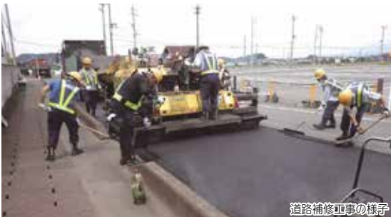
道路補修工事の様子
