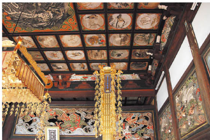
本堂内部の欄間彫刻と天井画
