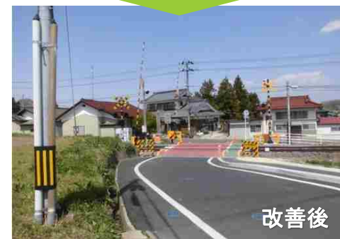
【踏切改善事例】福島県郡山市
