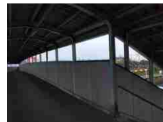
薄暗い跨線橋の様子
