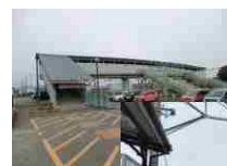
バリアフリー化されていない跨線橋・ホーム
