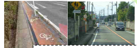
駅周辺の歩道と車道の様子
