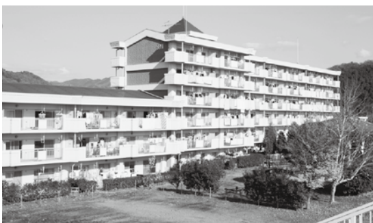
▲市営住宅（上原団地）
