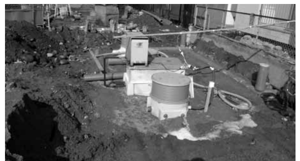
▲合併浄化槽
