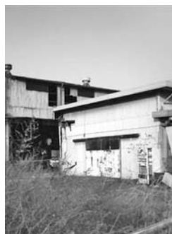
▲西鹿田地内の廃墟
