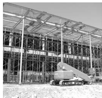
▲総合社会体育館建設現場
