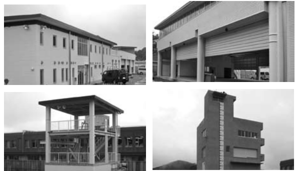
▲工事の進む新消防署
