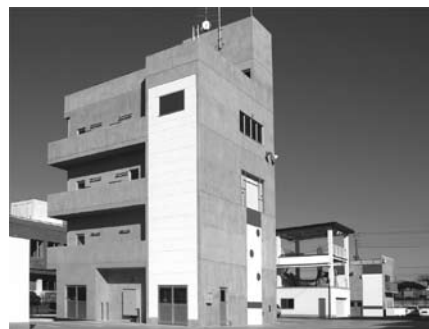
▲桐生みどり消防署訓練塔
