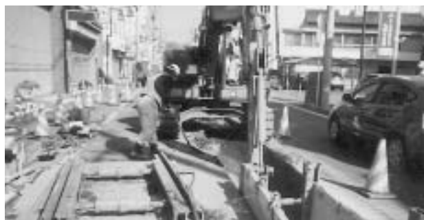
下水道工事(大間々町内)
