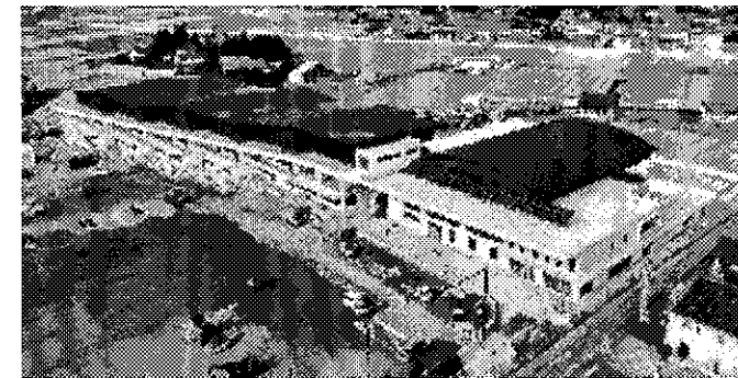
工事中の西小学校 (みどり市HPより)
