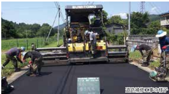
道路補修工事の様子
