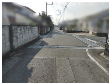
(排水溝整備／大間々町)
