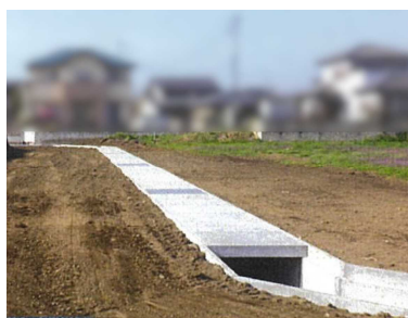
(排水路整備／大間々町)
