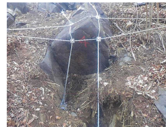
落石対策工事(市道2級35号線／東町)
