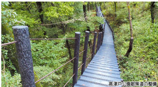
高津戸公園散策道の整備
