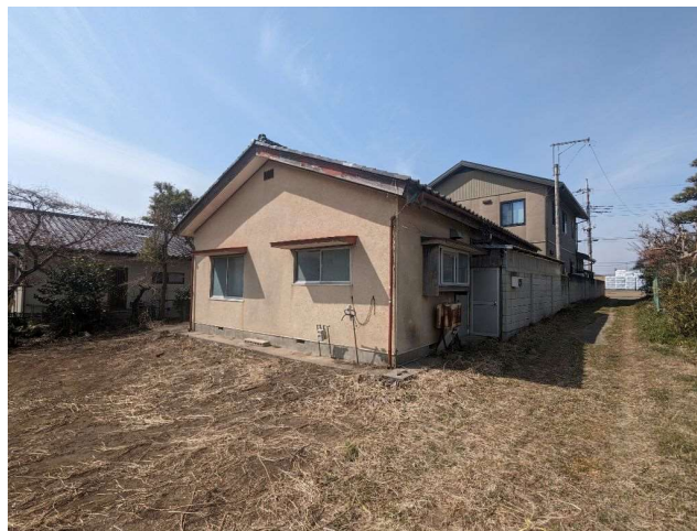
北東側から(道路状況)
