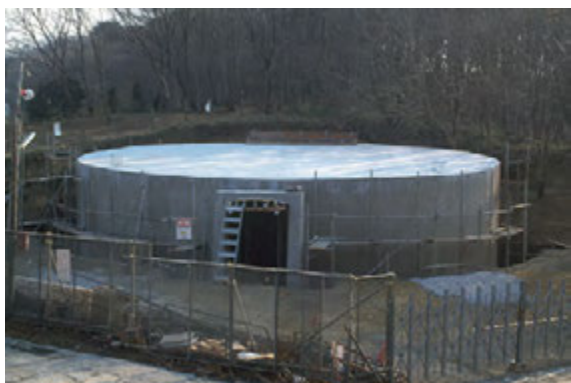
■写真9 遺構保護観察施設の整備（躯体工事）
