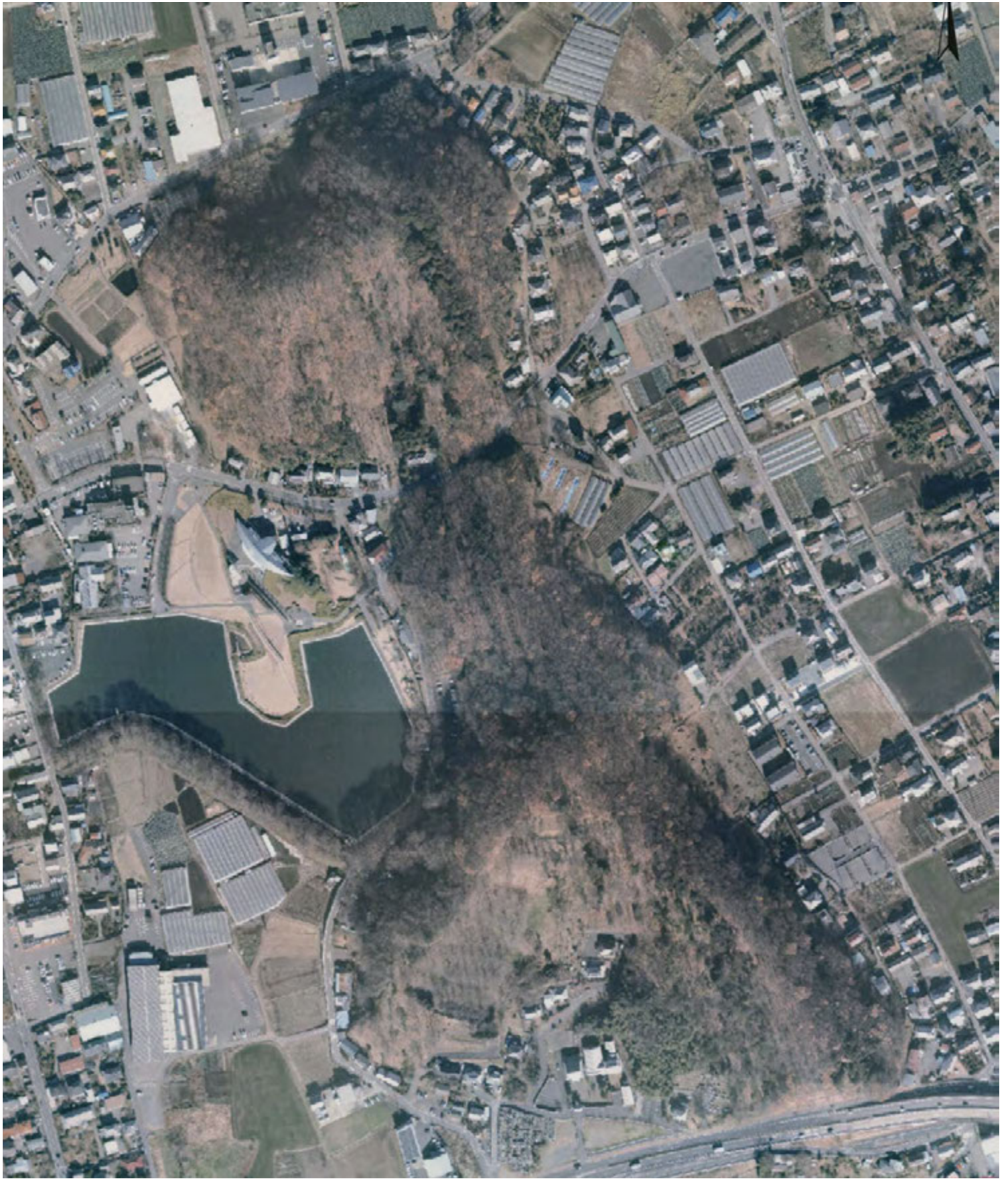
■写真 53 計画地及び周辺の現況（開発状況・植生等を含む）（縮尺：1/4,000）
