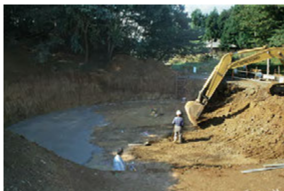
■写真8 遺構保護観察施設の整備（基礎の掘削）
