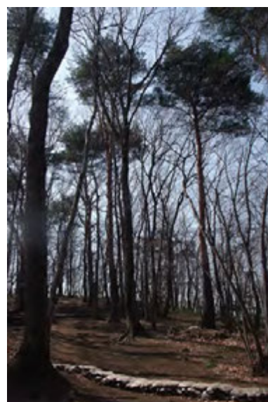
■写真 149 散策路の土砂流出対策のため応急にとられた措置（ゾーンⅣ、B地点付近）
