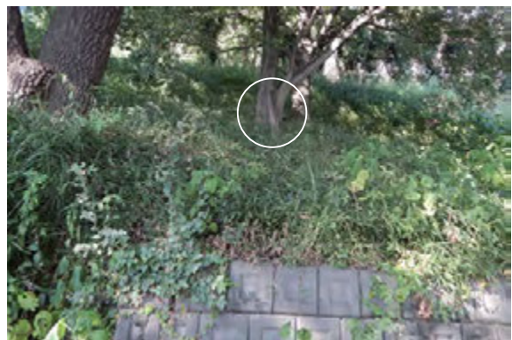
■写真142 D地点の現状（円内は朽ちた標柱）（ゾーンⅡ）
