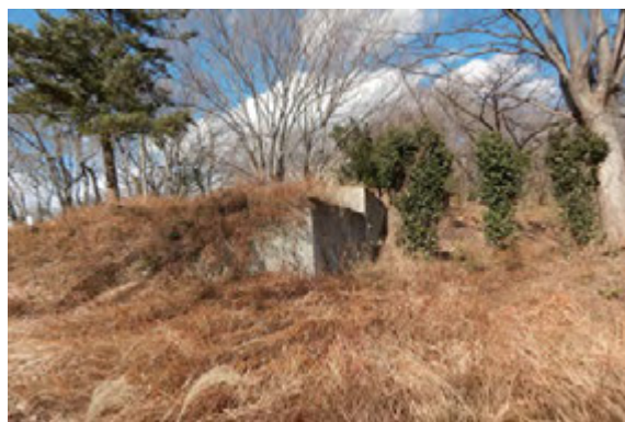
■写真 107 旧ゴルフ練習場の建物跡
