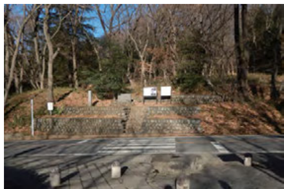
■写真 94 A地点（擁壁により地層が保護されている）
