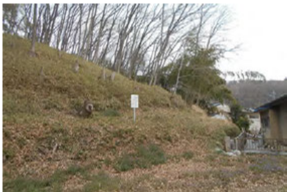
■写真 58 土砂災害警戒区域（堀上）
