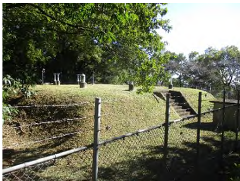
写真 3-3-13 史跡内上水道配水池
