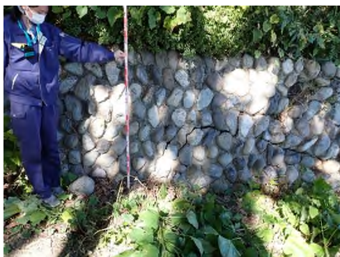
写真 3-3-5 擁壁の亀裂
