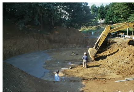
写真 3-2-19 遺構保護観察施設の掘削
