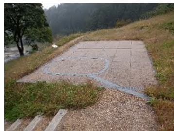
木チップ舗装（手前）、透水性コンクリート平板舗装（奥）（荒船風穴）
