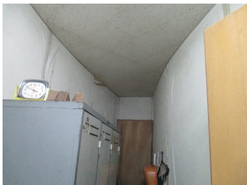
写真 3-3-15 史跡岩宿遺跡遺構保護観察施設
