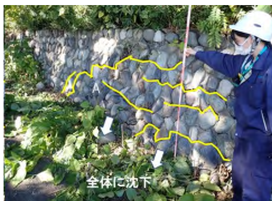
写真 5-2-3 擁壁のクラック状態
