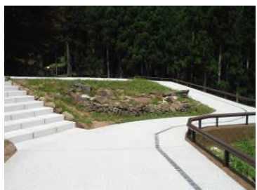
洗い出しコンクリート舗装（荒船風穴）
