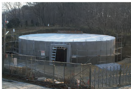
写真 3-2-20 遺構保護観察施設の躯体工事
