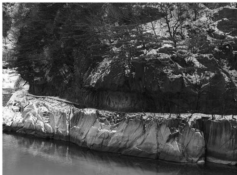
絶壁をコの字型に掘り馬車鐵道の軌道を敷設した
