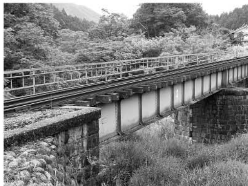
旧琴平トンネル (右下) 小中川橋りょう (下) 上神梅駅舎 (左)
