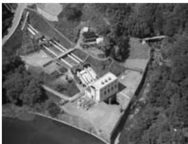
に水利問題が発生したため、しばらくは発電能力を十分に発揮することができなかつたようです。その後、東京電力に移管された福岡発電所は、現在も認可最大出力7,400キロワットで発電をしています。渓谷にたえず巨大な水圧鉄管は、今でも見る者を圧倒します。
