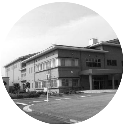
桐生市境野水処理場
