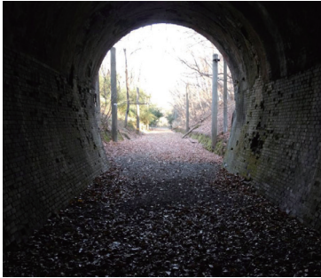
▲漆久保トンネル
