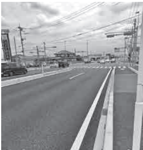
4車線化で大きく拡幅された信号交差点
