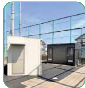
管理棟とトイレを改修
