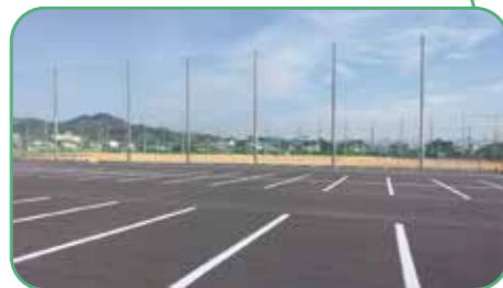
駐車場をアスファルト舗装
