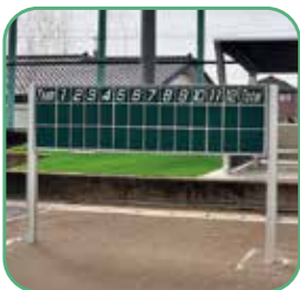
スコアボードを改修
