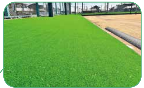
観客スタンドに人工芝を敷設
