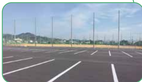
駐車場をアスファルト舗装
