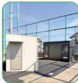
管理棟とトイレを改修
