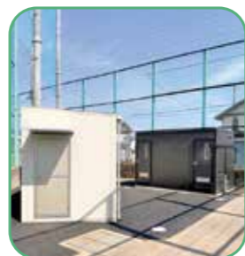
管理棟とトイレを改修
