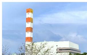
焼却：六供清掃工場
