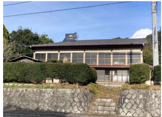
全面道路から
