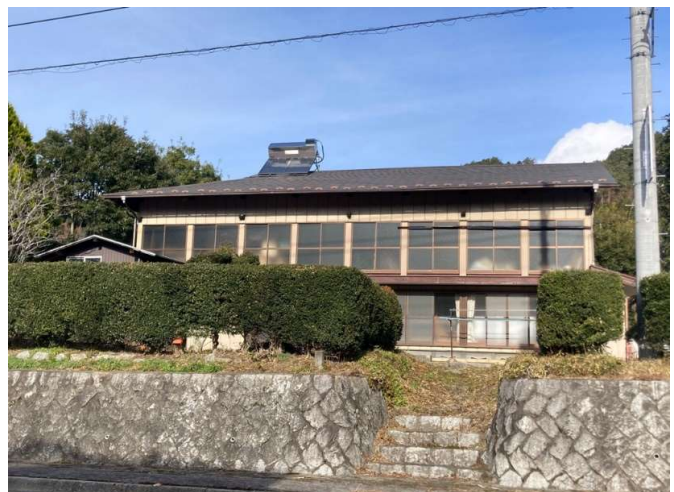
全面道路から
